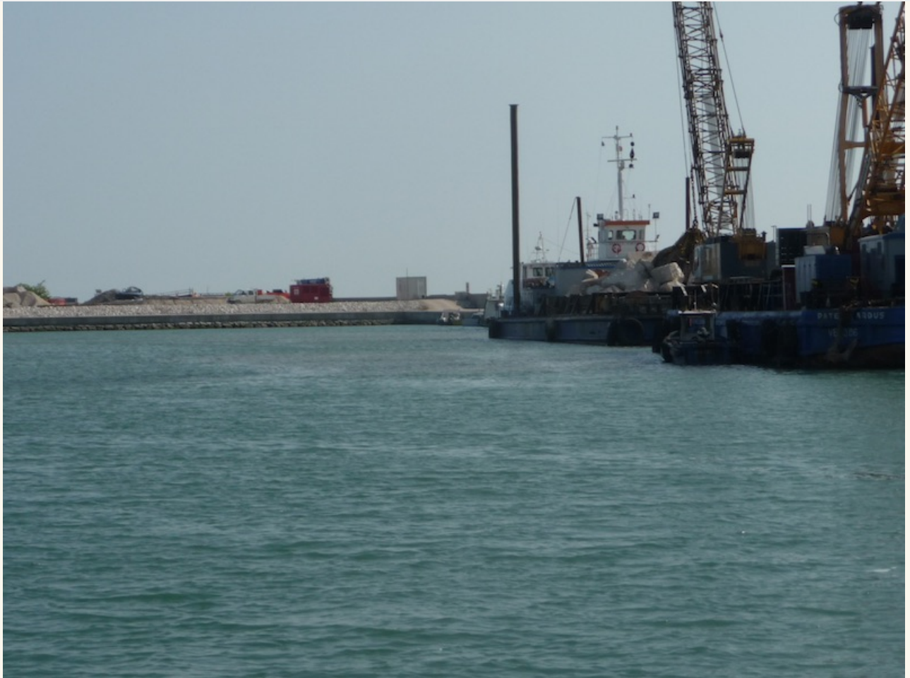
Riesige Schwimmkräne arbeiten an der Aufschüttung der Schutzdämme .
